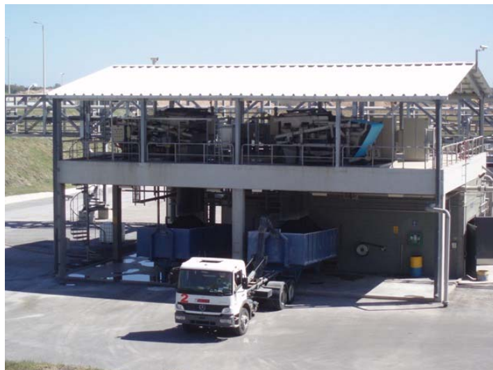
Camión retirando lodo primario con destino a las plantaciones
